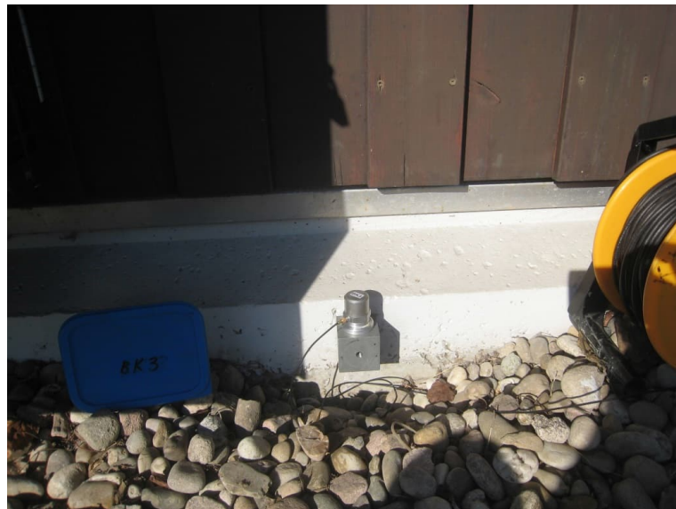
Abbildung 22: MO-4 Messpunkt Außenmesspunkt
