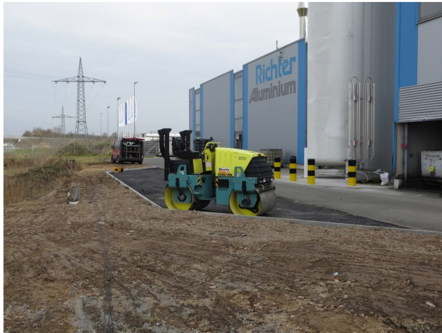
Abbildung 44: MO-7 - Nordwestlicher Hallenteil
