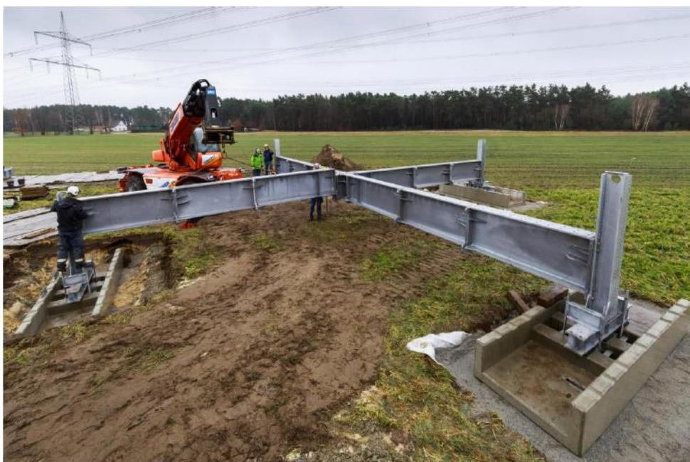
**Abbildung 18: Auflastprovisorium - Mastfuß mit Schotterbetten (Quelle Amprion)**
