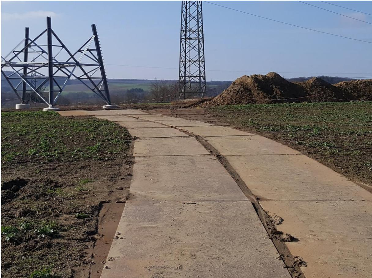
**Abbildung 19: Temporäre Zuwegung über Fahrplatten (Quelle: Amprion GmbH)**
