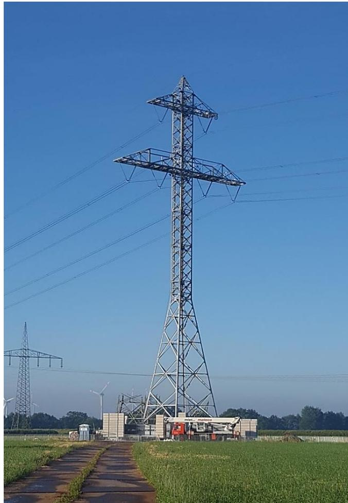
**Abbildung 17: Fertiges Provisorium (Quelle Amprion)**
