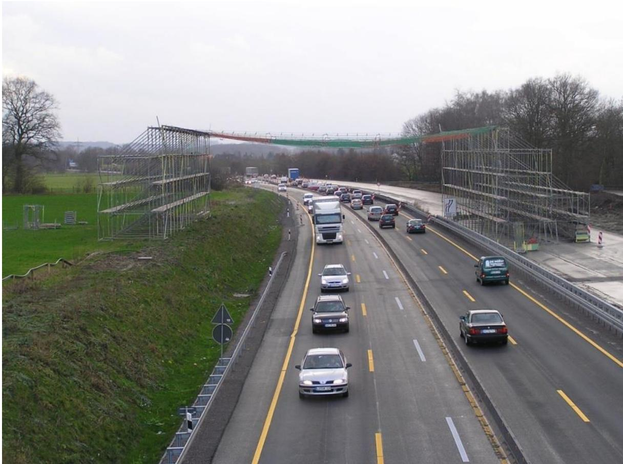
**Abbildung 27: Stahlrohrschutzkonstruktion mit Netz über einer Autobahn (Quelle: Amprion GmbH)**
