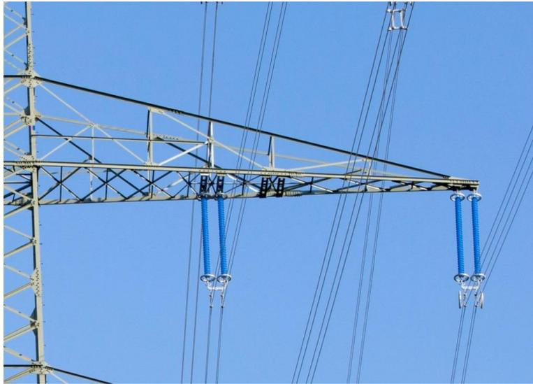
**Abbildung 16: Isolatorketten mit (rechts) und ohne (links) Feldsteuereinheit (Quelle: Amprion GmbH)**
