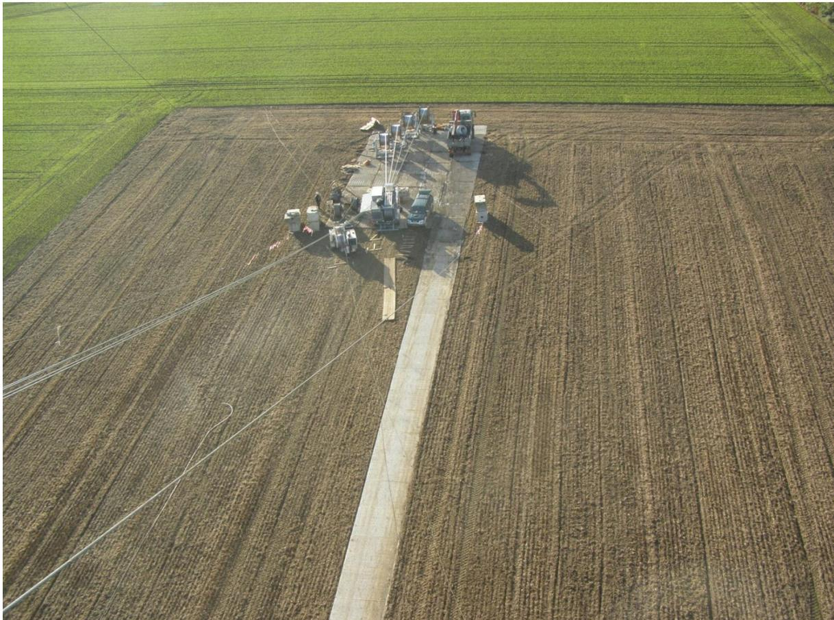
**Abbildung 25: Windenplatz eines Viererbündel-Seilzuges (Quelle: Amprion GmbH)**
