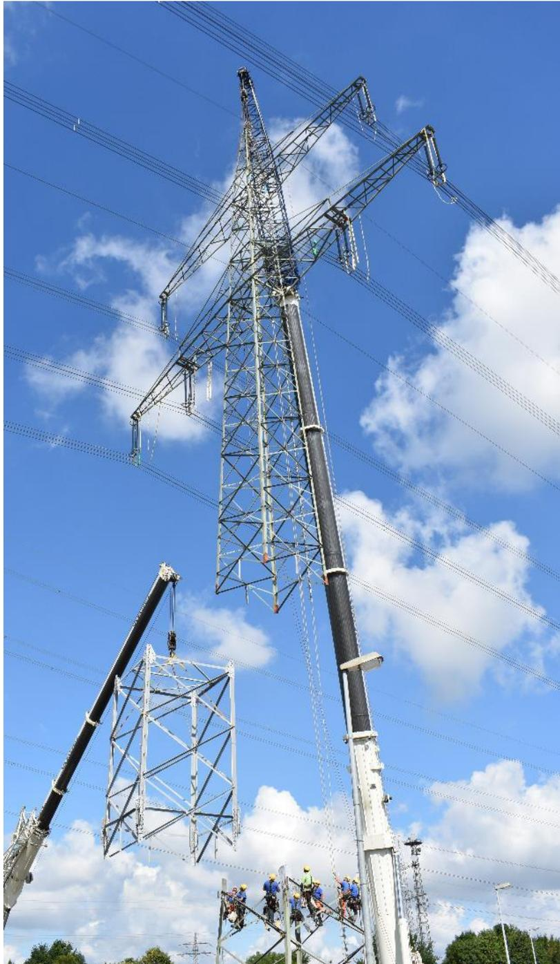
**Abbildung 2-5 Mastmontage (Einbau Zwischenschuss)
