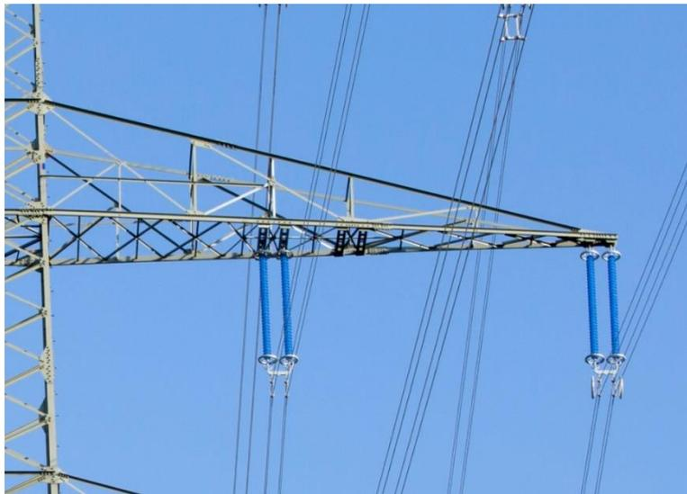
**Abbildung 2-1 Isolatorketten mit (rechts) und ohne (links) Feldsteuereinheit
