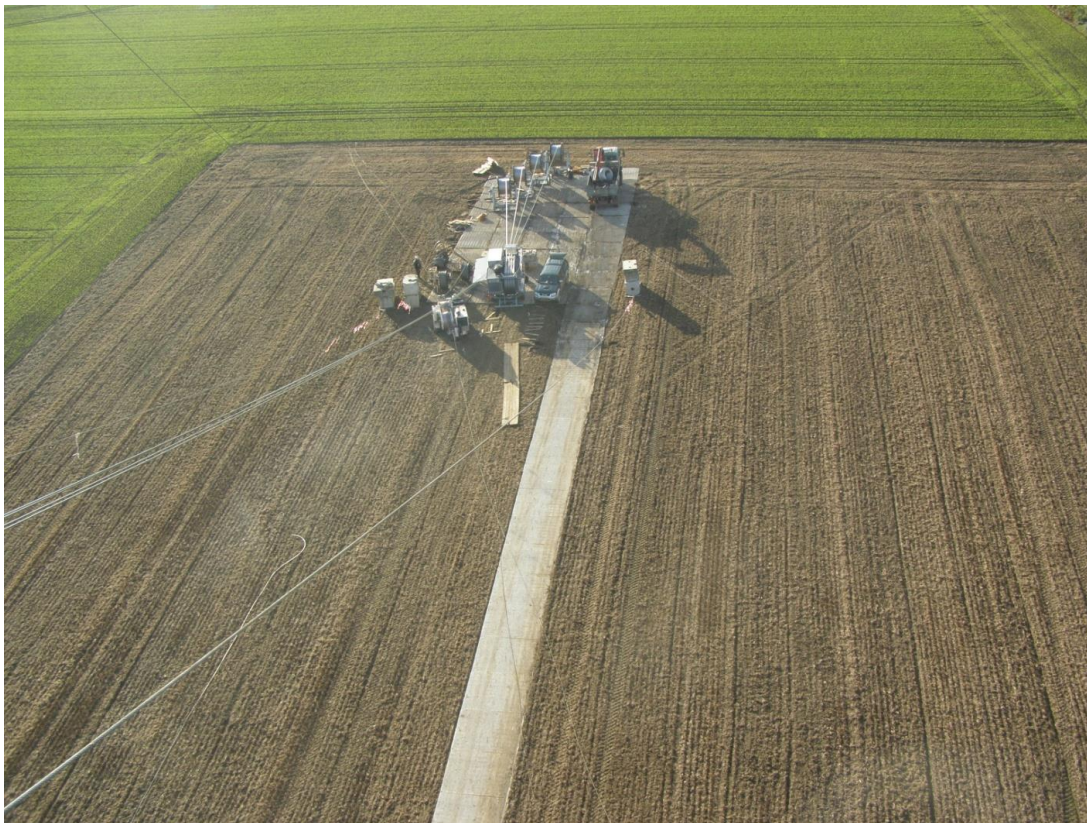
Abbildung 18: Windenplatz eines Viererbündel-Seilzuges (Quelle: Amprion GmbH)
