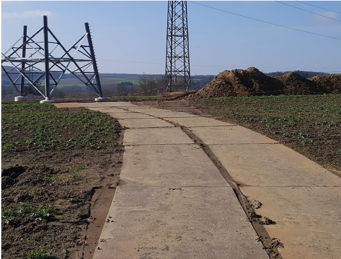
Abbildung 8: Temporäre Zuwegung über Fahrplatten (Quelle: Amprion GmbH)
