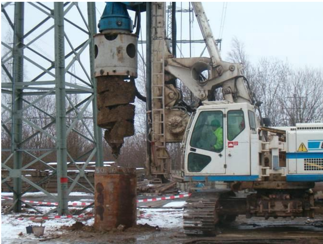
Abbildung 13: Bohrung für einen Bohrpfahl (Quelle: Amprion GmbH)
