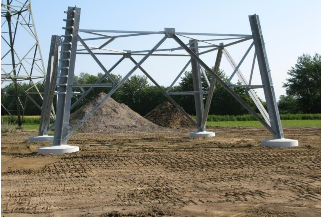
Abbildung 14: Montierter Mastfuß (Quelle: Amprion GmbH)
