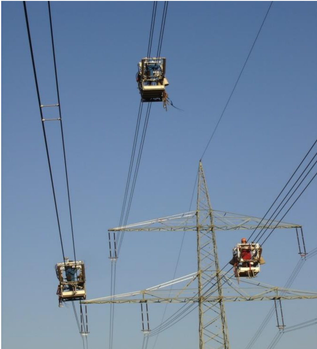
Abbildung 19: Montage der Feldbündelabstandhalter mit Fahrwagen (Quelle: Amprion GmbH)
