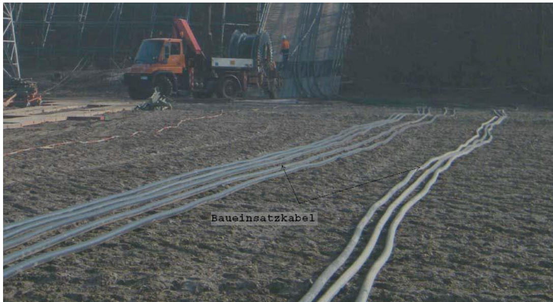
Abbildung 7: Verlegung von Baueinsatzkabel als Provisorium für 110-kV-Leitungen (Quelle Amprion)
