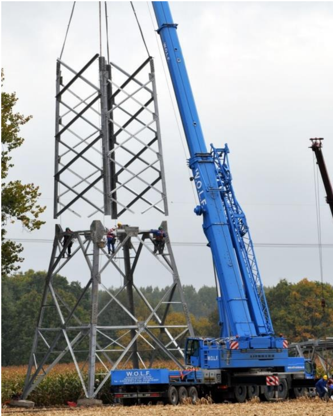
Abbildung 15: Mastmontage (Stocken) (Quelle: Amprion GmbH)
