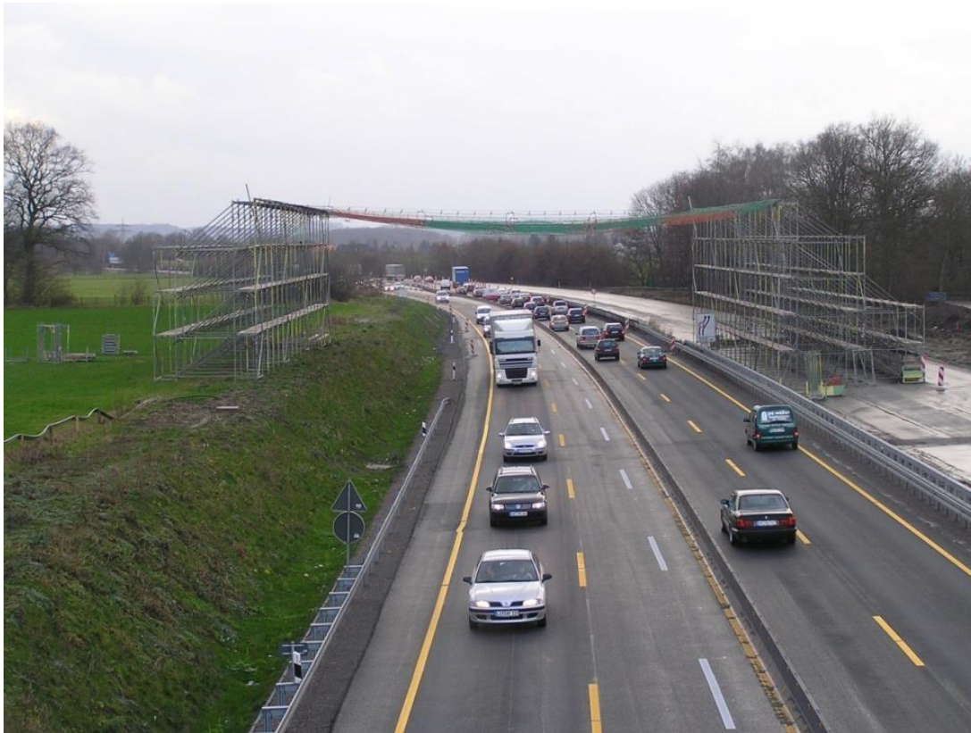
Abbildung 17: Stahlrohrschutzkonstruktion mit Netz über einer Autobahn (Quelle: Amprion GmbH)
