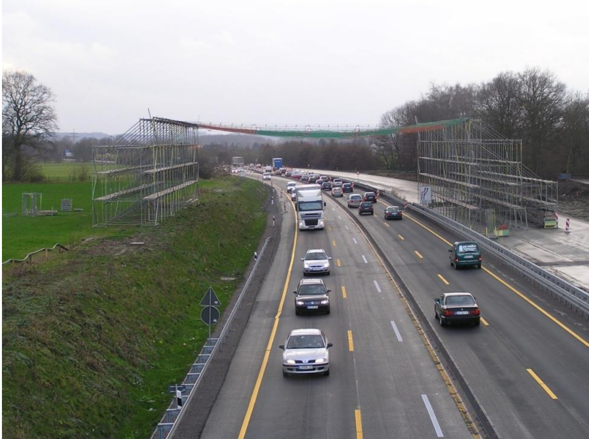
Abbildung 3-12: Stahlrohrschutzkonstruktion mit Netz über einer Autobahn (Quelle: Amprion GmbH)
