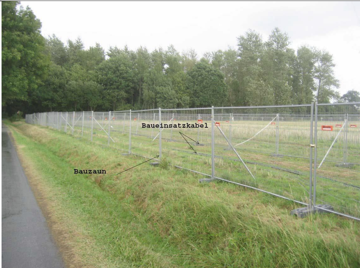
Abbildung 3-1: Baueinsatzkabel für 110-kV-Leitungen mit Sicherheitszaun (Quelle: Amprion GmbH)
