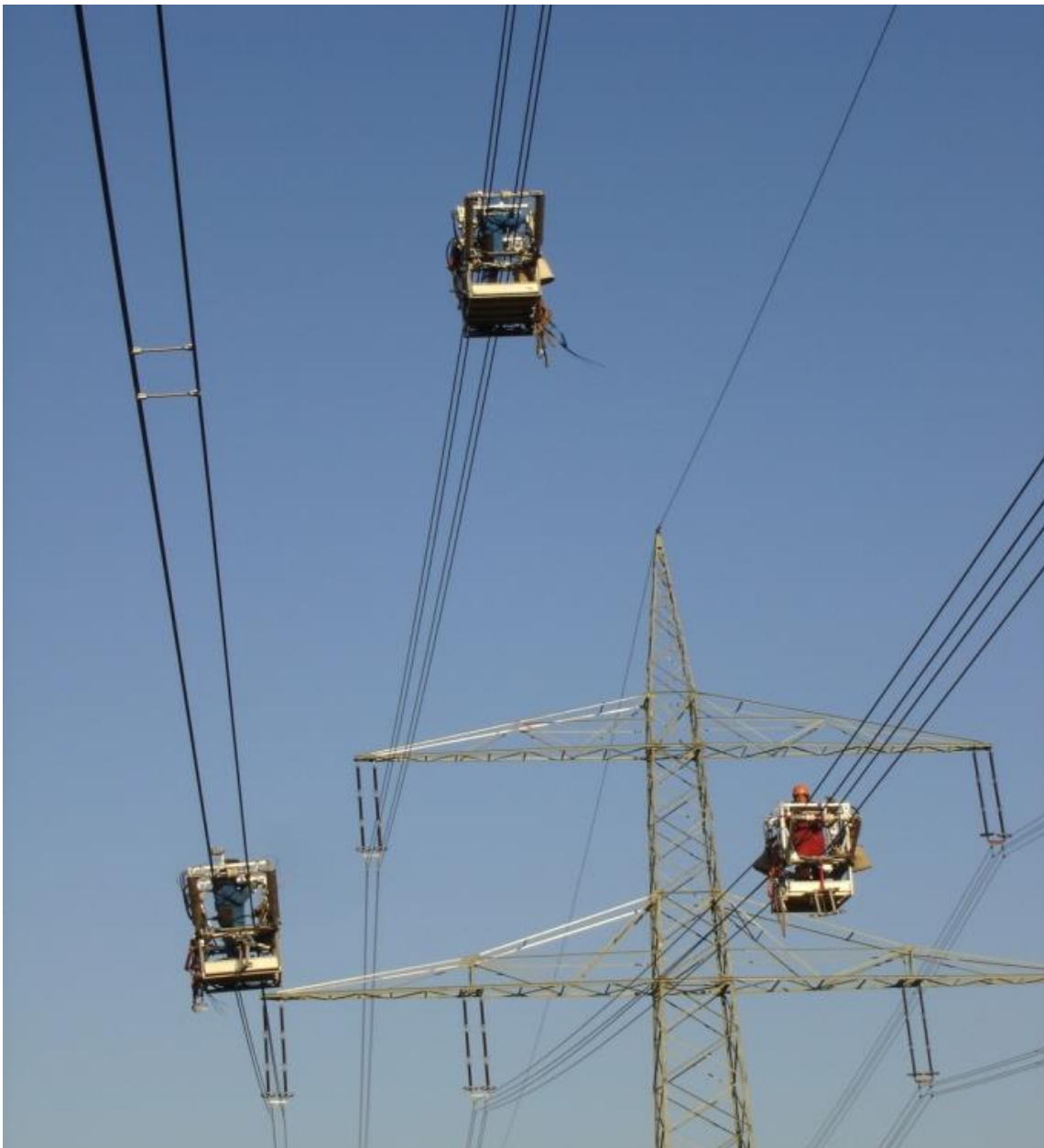
Abbildung 3-14: Montage der Feldbündelabstandhalter mit Fahrwagen (Quelle: Amprion GmbH)
