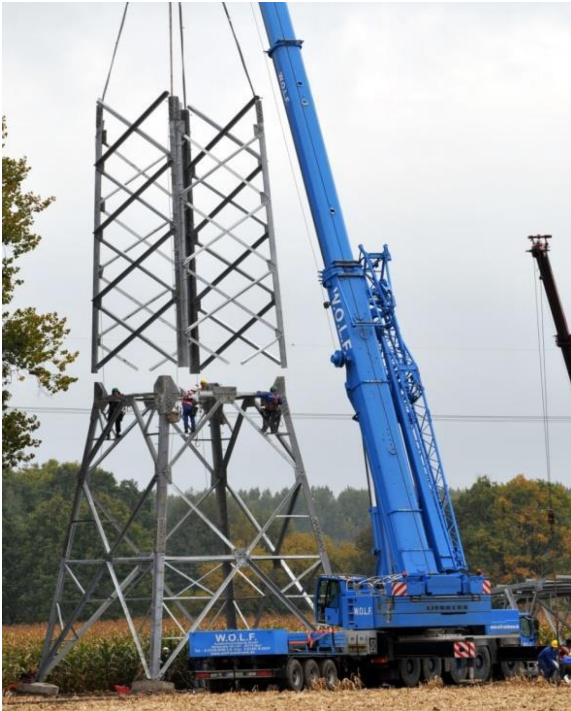
Abbildung 3-10: Mastmontage (Stocken) (Quelle: Amprion GmbH)
