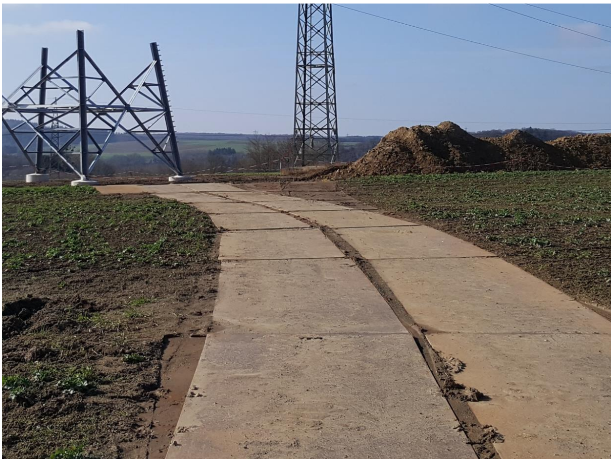
Abbildung 3-3: Temporäre Zuwegung über Fahrplatten (Quelle: Amprion GmbH)
