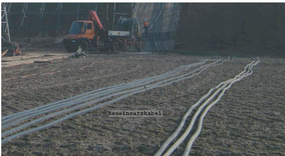
Abbildung 3-2: Verlegung von Baueinsatzkabel als Provisorium für 110-kV-Leitungen (Quelle Amprion GmbH)
