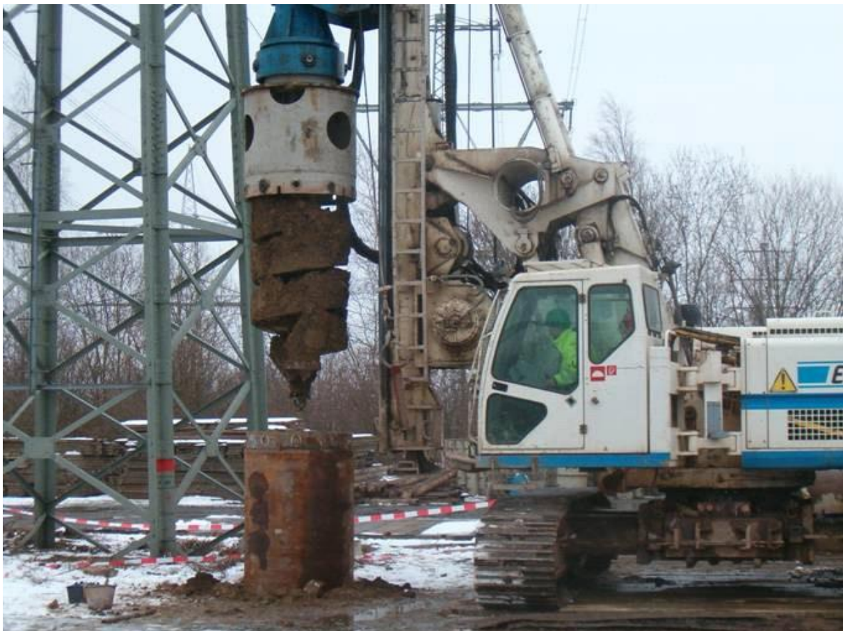
Abbildung 3-8: Bohrung für einen Bohrpfahl (Quelle: Amprion GmbH)
