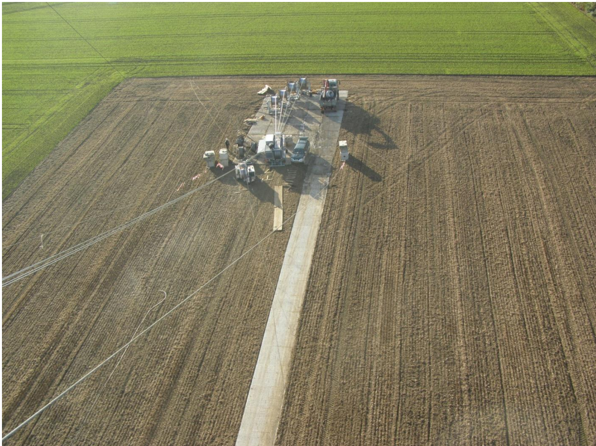
Abbildung 3-13: Windenplatz eines Viererbündel-Seilzuges (Quelle: Amprion GmbH)
