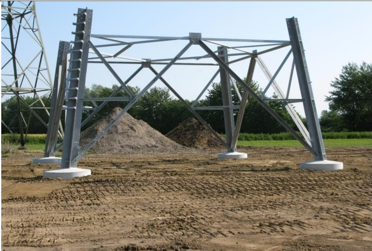
Abbildung 3-9: Montierter Mastfuß (Quelle: Amprion GmbH)
