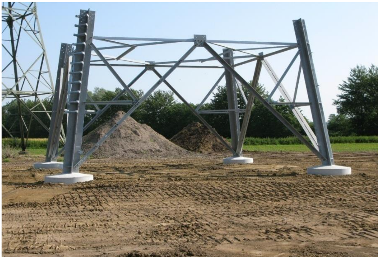
Abbildung 3-7 Montierter Mastfuß (Quelle: Amprion GmbH)
