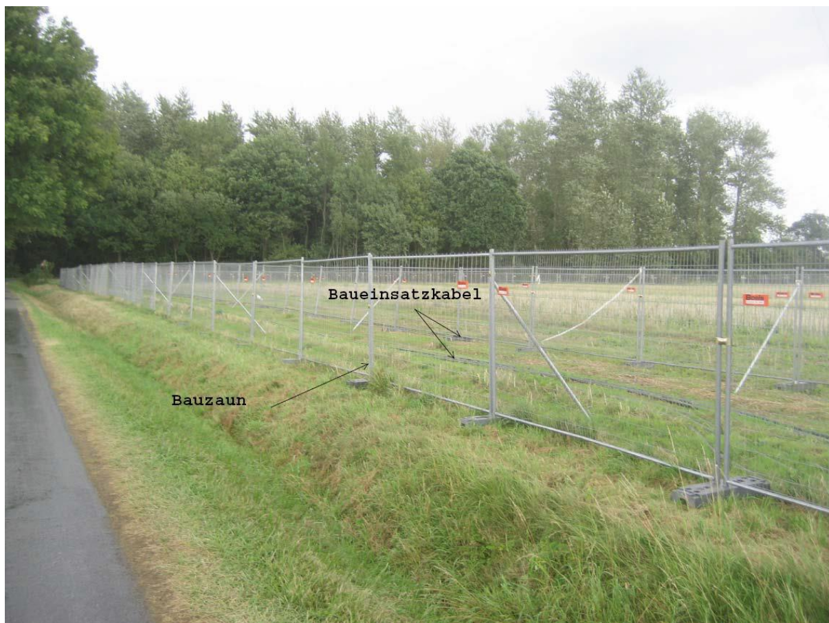
Abbildung 3-1 Baueinsatzkabel für 110-kV-Leitungen mit Sicherheitszaun (Quelle: Amprion)
