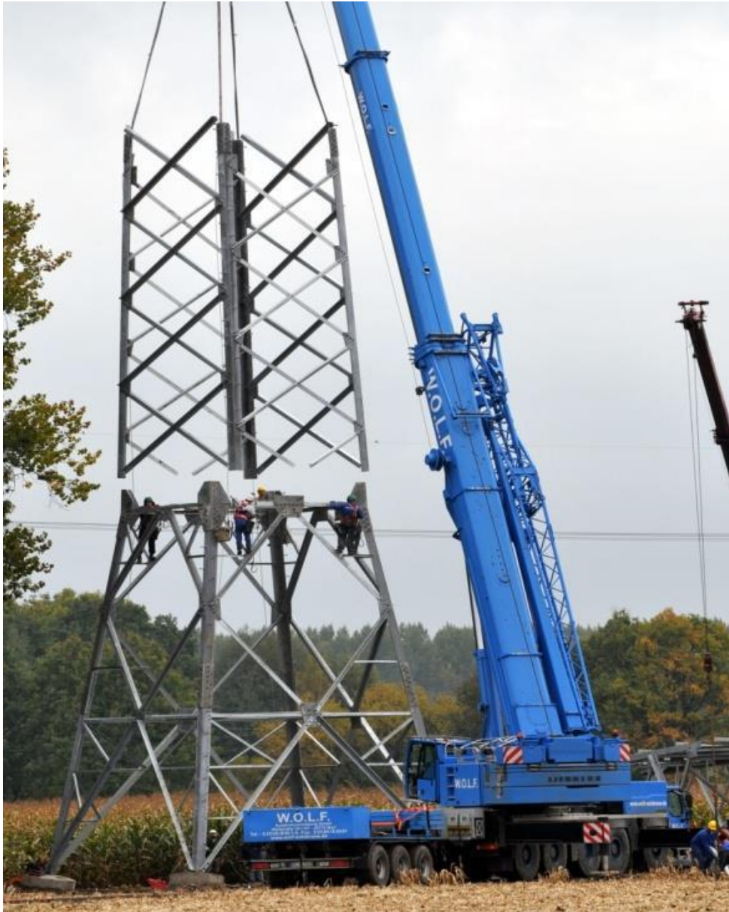
Abbildung 3-8 Mastmontage (Stocken) (Quelle: Amprion GmbH)
