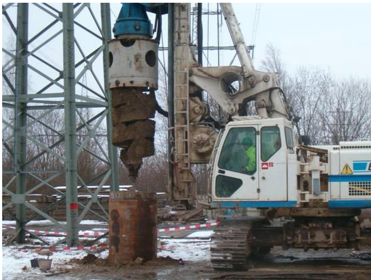
Abbildung 3-6 Bohrung für einen Bohrpfahl (Quelle: Amprion GmbH)
