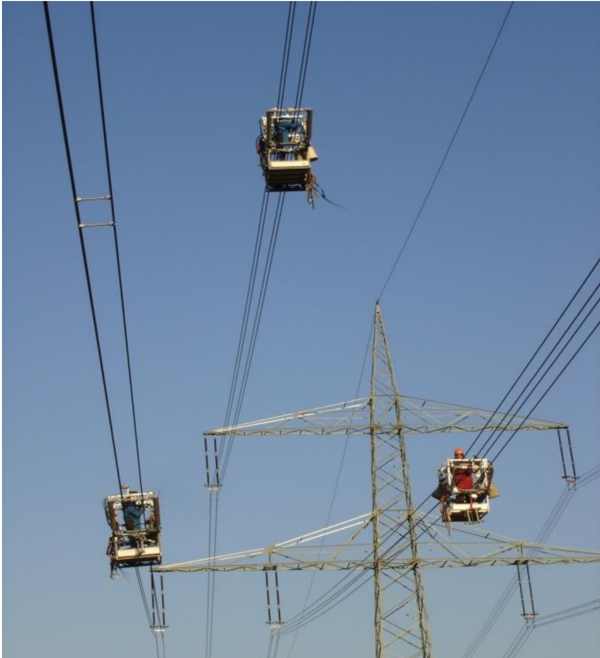
Abbildung 3-12 Montage der Feldbündelabstandhalter mit Fahrwagen (Quelle: Amprion GmbH)
