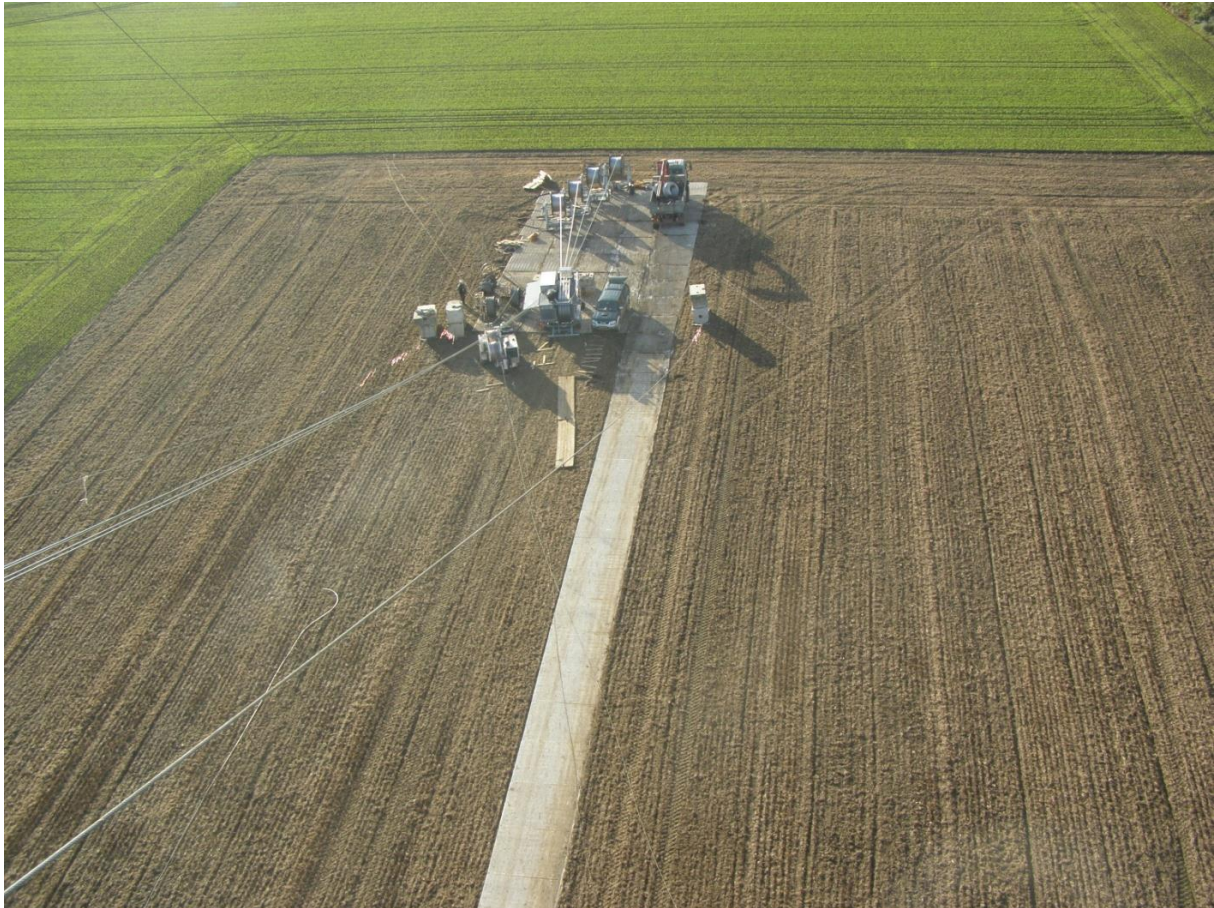
Abbildung 3-11 Windenplatz eines Viererbündel-Seilzuges (Quelle: Amprion GmbH)
