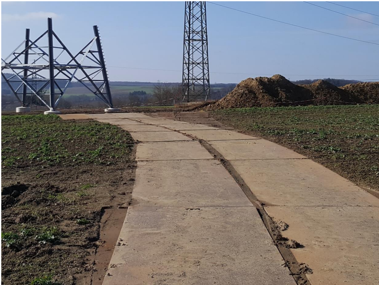
Abbildung 3-2 Temporäre Zuwegung über Fahrplatten (Quelle: Amprion GmbH)
